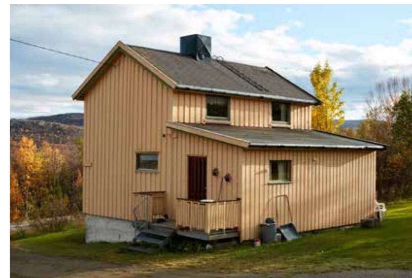
Gjenreisningshuset til familien Pedersen i Ytre Billefjord, Porsanger. Huset ble bygd i 1947 og her vokste det opp 11 barn. Mange hus fikk etter hvert tilbygg med bad. Dette huset ble påbygd på 1970-tallet. Huset blir nå brukt som feriebolig. Foto: Haakon Harriss/Norsk Folkemuseum.
