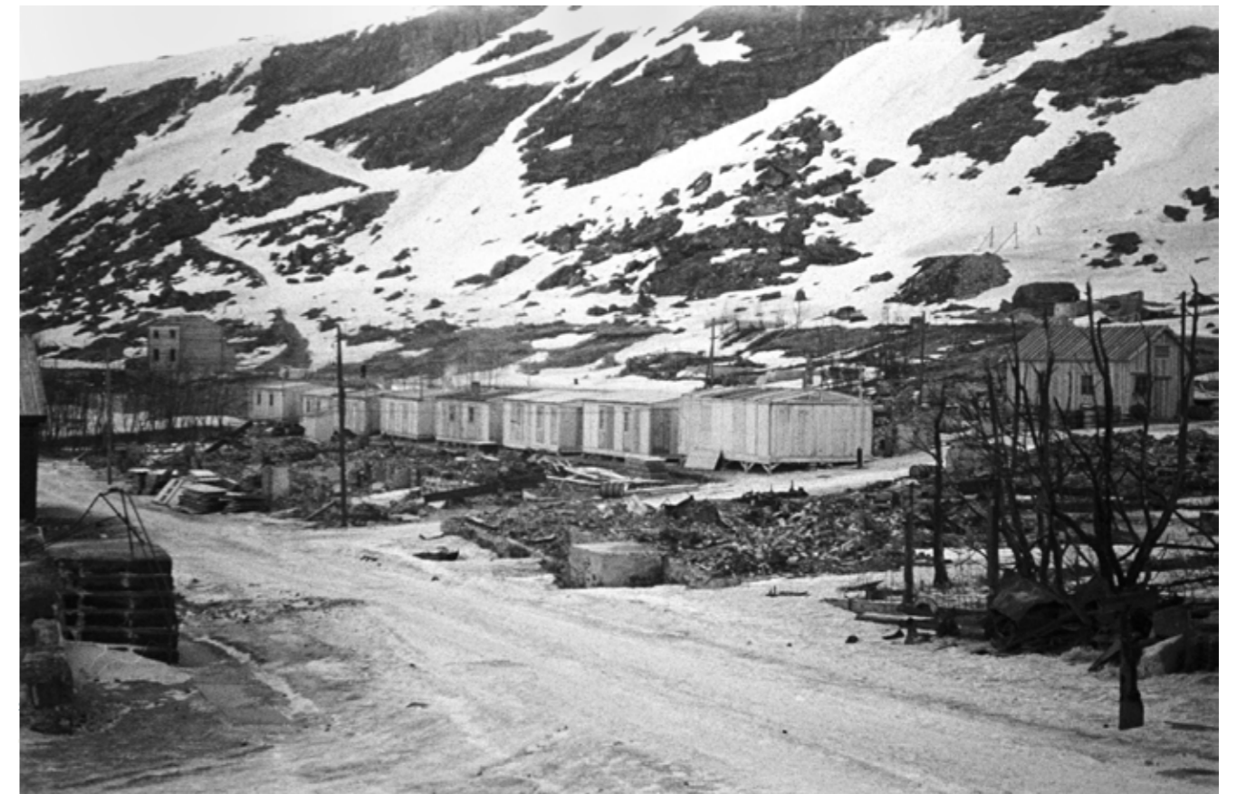
Brakker i Nedre Grønnevdsgate i Hammerfest sentrum 1946-1947. Gjenreisningen har begynt. Vi ser de såkalte «Majabrakkene» under oppføring – oppkalt etter Maja Mathisen som satt i bygningsrådet i Hammerfest. Foto: Fridtjof Johan Jacobsen/Arkiv: Finnmark fylkesbibliotek.
