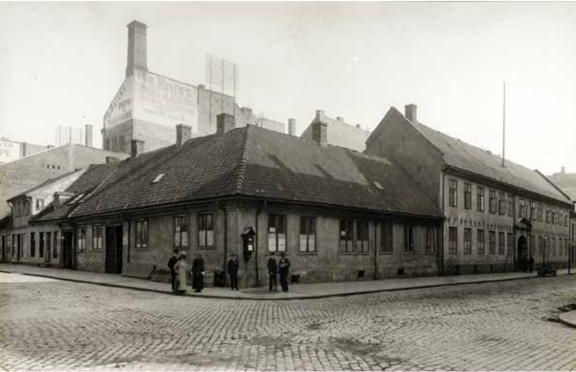
Kongens gate 6 lå på hjørnet mellom Kongens gate og Rådhusgaten. Foto: O. Væring, 1910. Norsk Folkemuseum.
